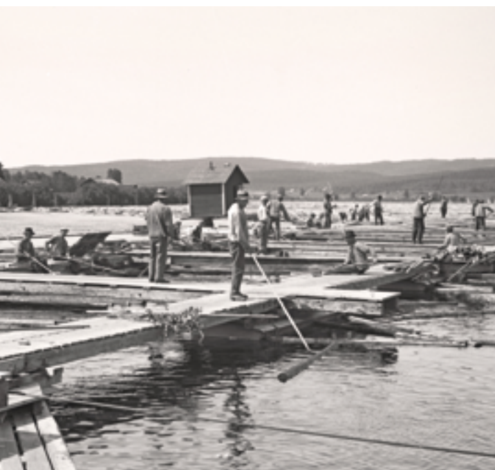
Skiftning av virke vid Tägtens skiljeställe.
